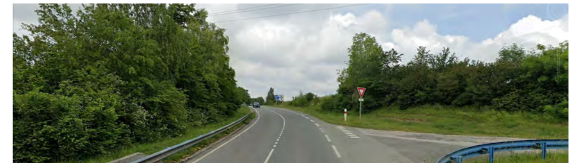
Figure 45. Point de vue révélateur D en direction de la ZIP (source : Street View)
