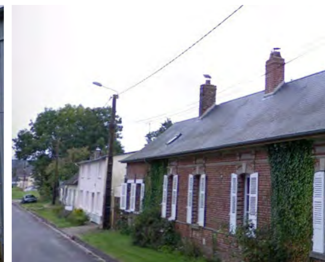
Figure 32. Maison rue d'Arras
