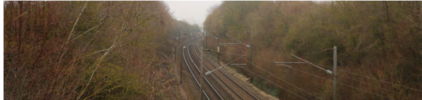
Figure 28. Voie ferrée rejoignant Albert puis Arras
