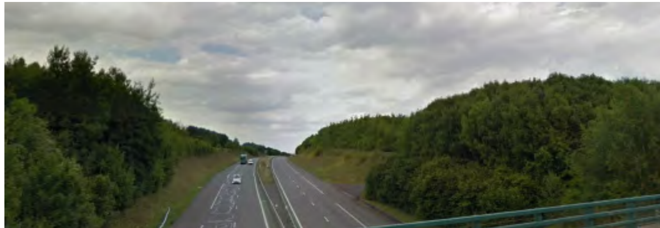
Figure 22. Vue depuis un pont au-dessus de l'A16 à proximité de Saveuse
