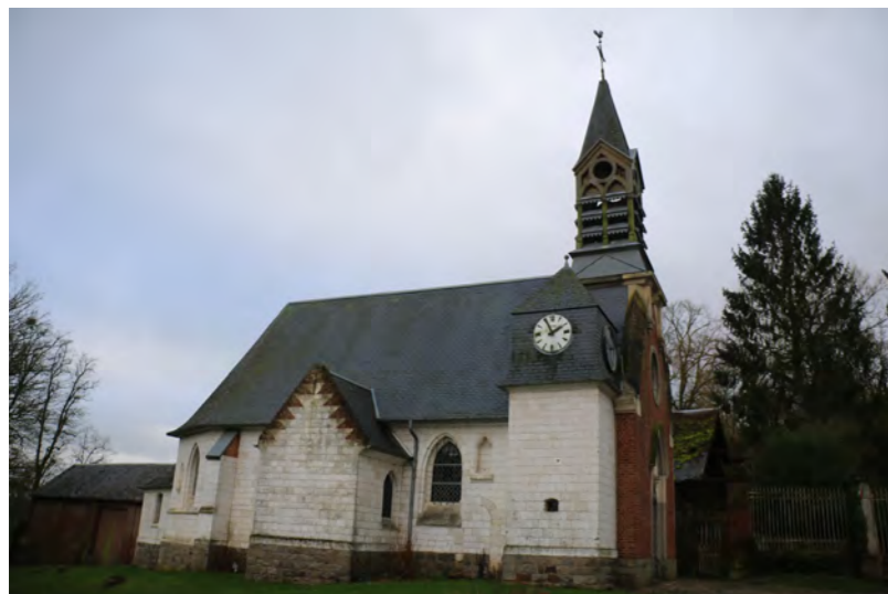
Figure 55. Église de Montonvilliers
